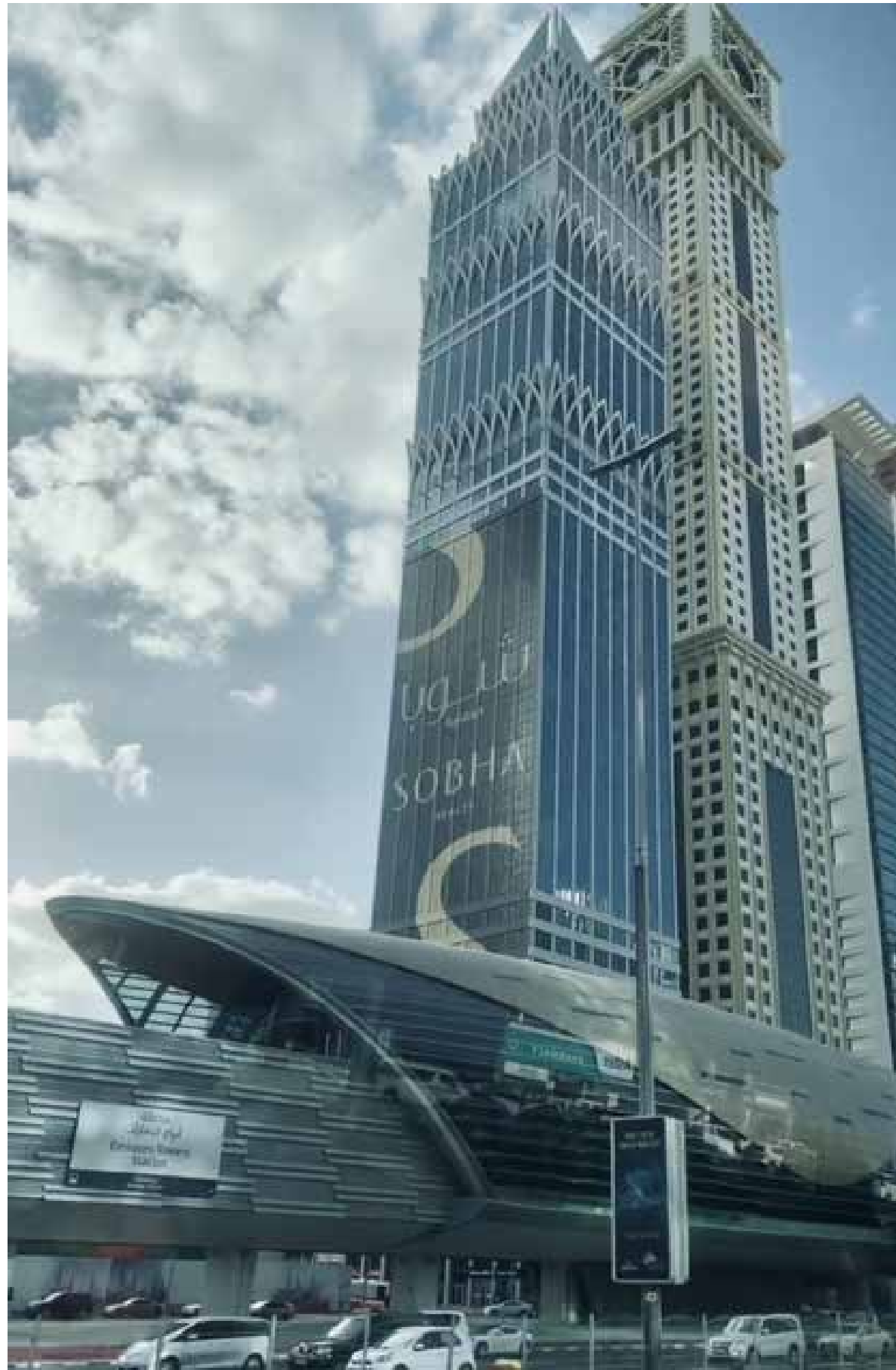
Stazione metro: 74,6 Km di rete metropolitana. La più lunga del mondo senza conducente Estação de metrô: 74,6 Km de rede subterrânea. O mais longo do mundo, sem motorista
