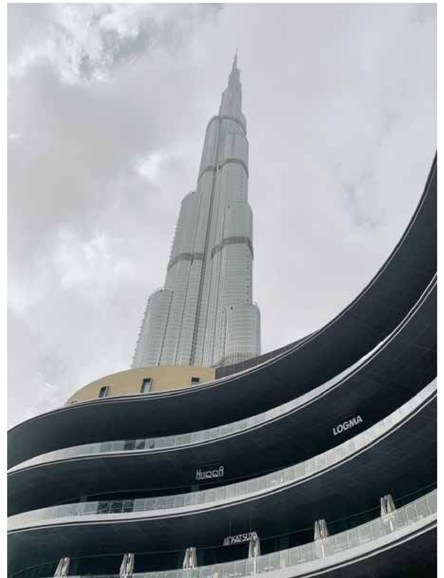
Bury Khalifa: il grattacielo più alto del mondo. La più alta struttura realizzata dall'uomo misura 829,80 metri Burj Khalifa: o arranha-céu mais alto do mundo. A estrutura mais alta feita pelo homem mede 829,80 metros
